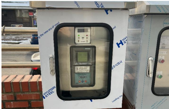
역세수 적산유량 및 pH 디스플레이 패널 설치
