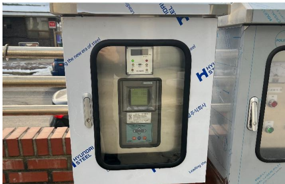
역세수 적산유량 및 pH 디스플레이 패널 설치
